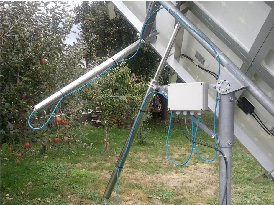
Bevor Sie die Anschlussdose verkabeln, entfernen Sie die **transparente Sicherung**, sodass sich der Indikator auf der Anschlussplatine ausschaltet.
